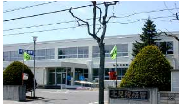
(北見税務署は昭和22年8月開庁、写真の建物は昭和42年12月完成)
