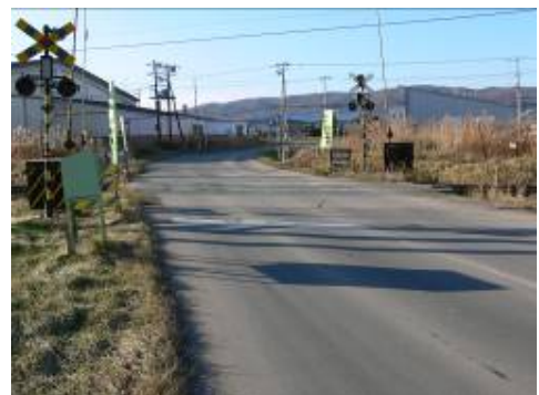
↑ 端野町13号線道路（踏切）
