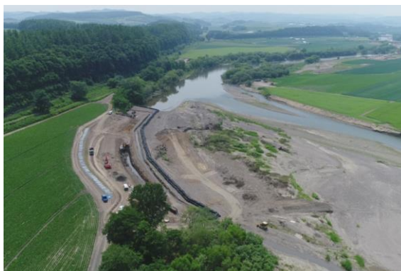
▲常呂川災害復旧工事（一区 東19号地先） 急ピッチに工事が進められています
