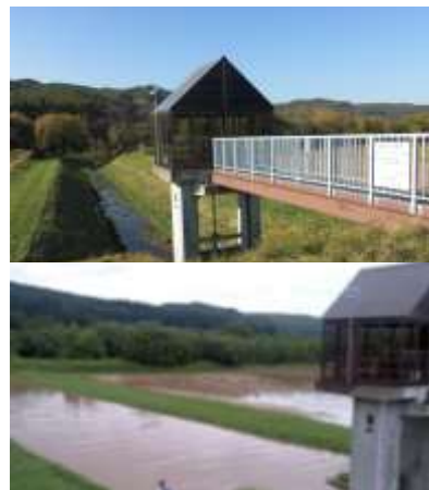
▲端野右岸樋門 早期の排水ポンプ設置を
