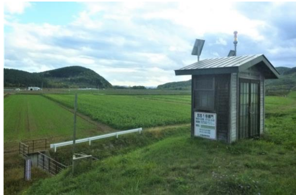
▲忠志1号樋門 「早期の排水ポンプ設置を」
