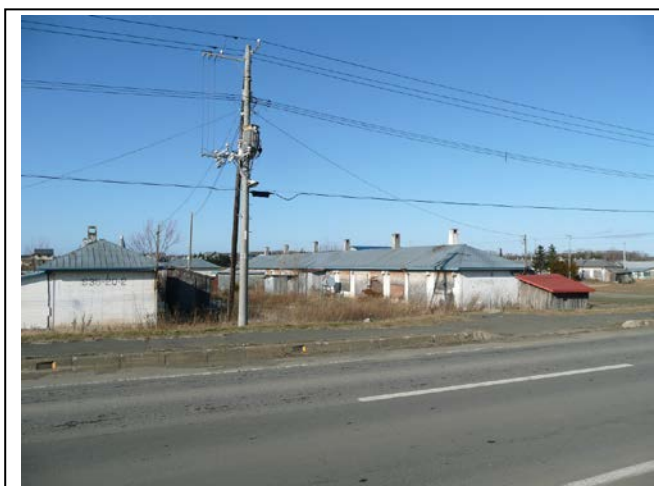
防犯上や景観上の懸念となっている西町第2団地
