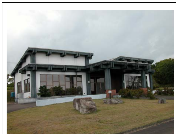
老朽化が著しい常呂町斎場
