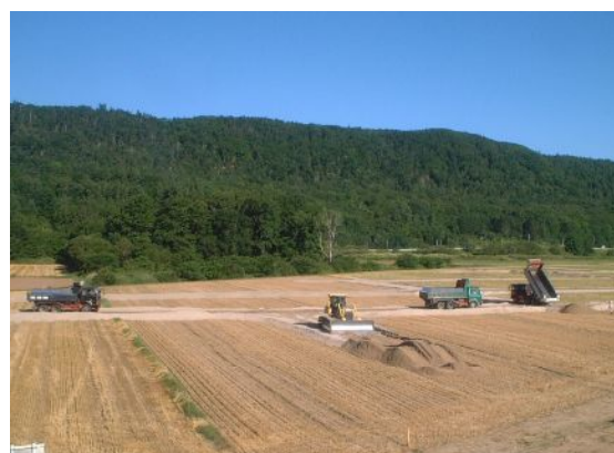
土地改良事業（客土工事）
