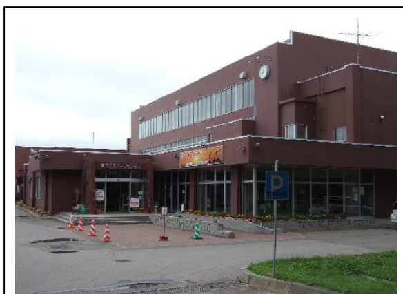
経年劣化が著しい常呂町スポーツセンター
