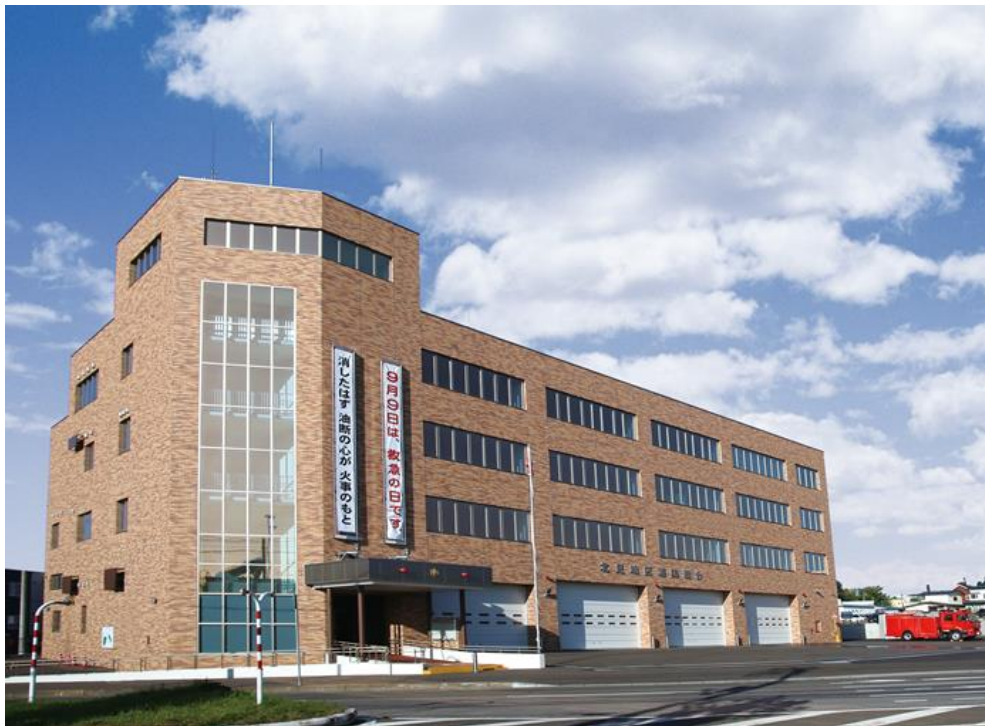
北見地区消防組合消防本部・消防署
