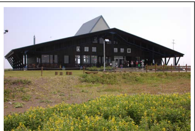
支柱の改修が急がれるサロマ湖ワッカネイチャーセンター
