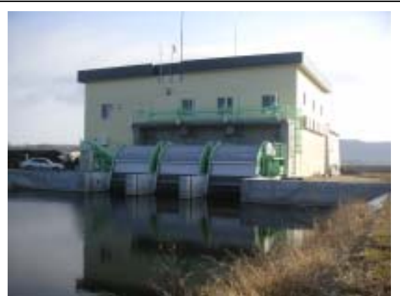
来年度から維持管理をする岐阜排水機場
