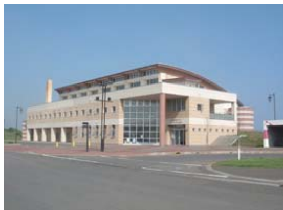
改修が急がれる常呂町健康温水プール
