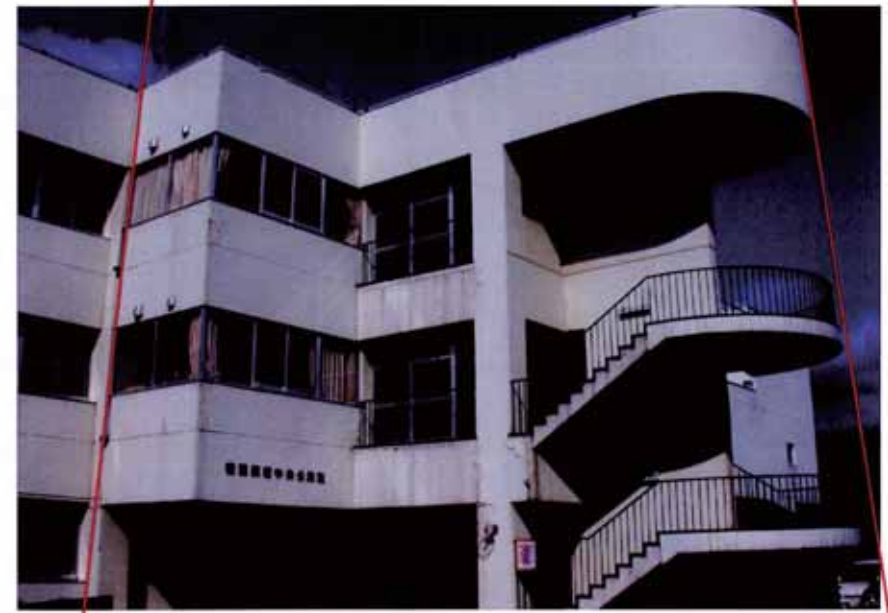
改修箇所全景
