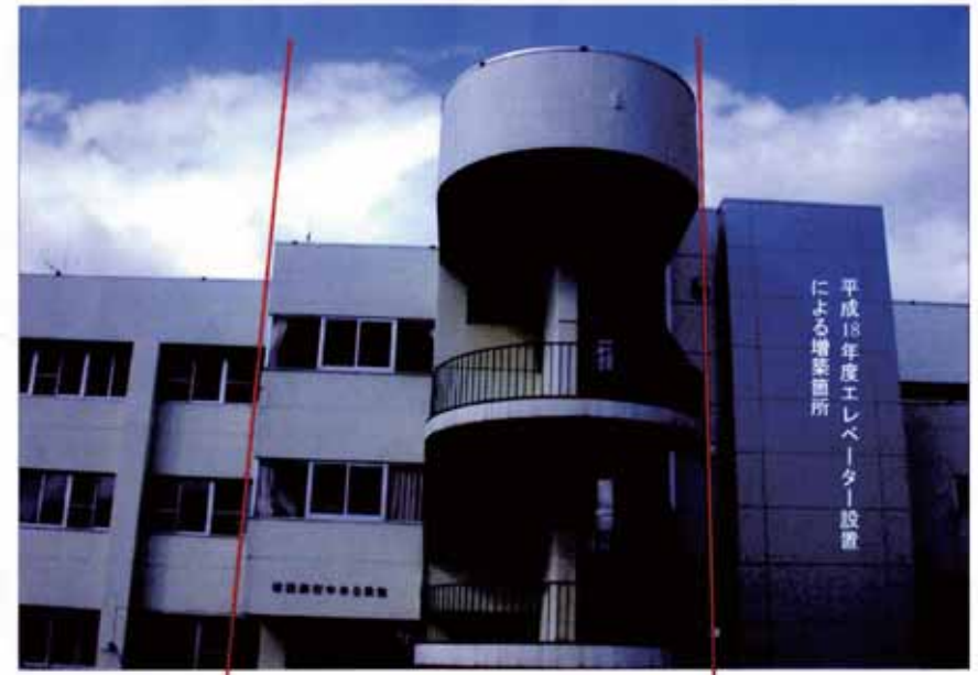
改修箇所正面
