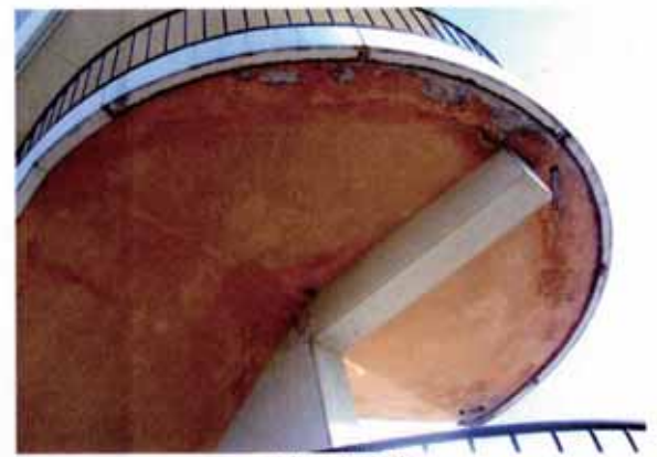
2階外階段下部
